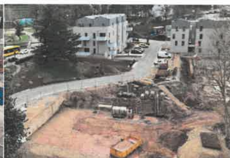
terrassement Epicéas (Aubépines/Buis à l'arrière)
